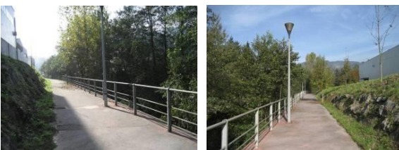
Estado actual de la zona baja del AIU 9
